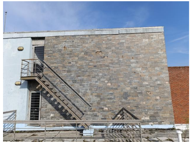
Cielorraso de hormigón visto bajo azotea a limpiar Muro con desprendimiento de piedras a reparar
